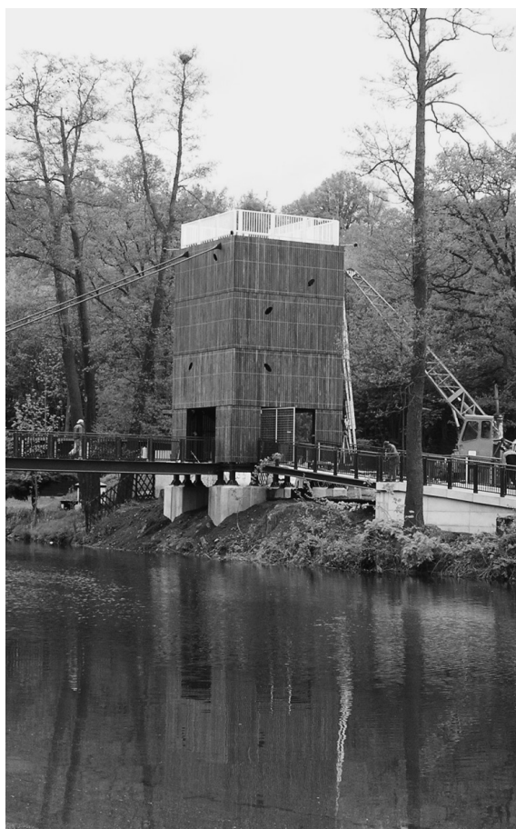
Lávka s vyhlídkovou věží v Chebu, foto: Lubomír Fuxa
