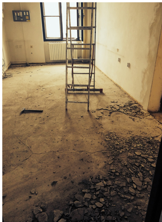
Rekonštrukcia depozitára, 2013. Foto: Maroš Schmidt.
