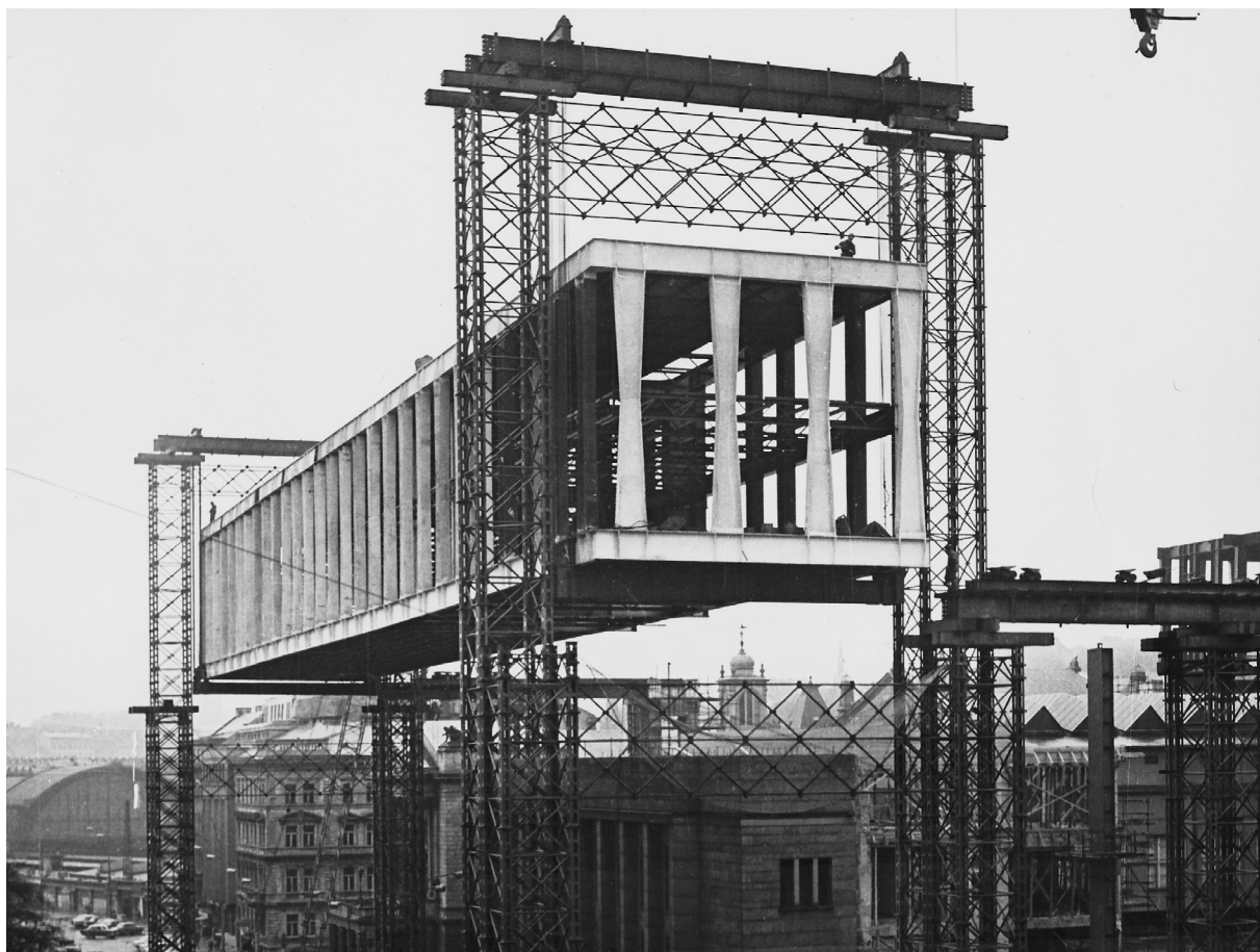
Zvedání Vierendelova nosníku - z výstavby budovy Národního shromáždění (snímek z konce 60. let)
