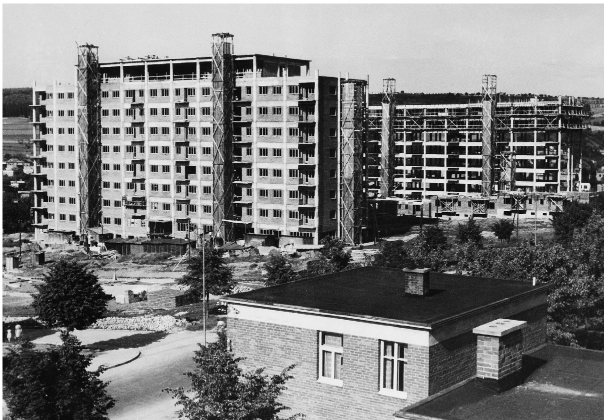
Výstavba Moravských domů, Zlín 1948
