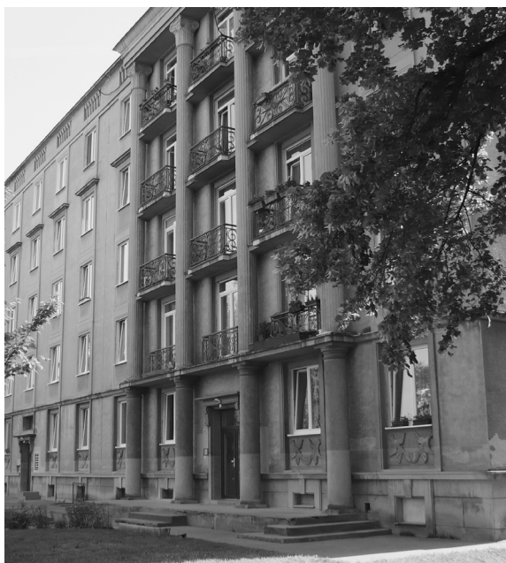
K. Janů, K. Prager: experimentální, částečně montovaný bytový dům v Otrokovicích (snímek 2009)
