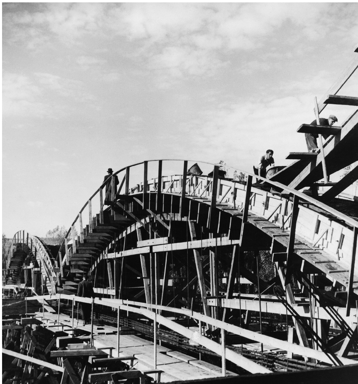
Bednění vrcholů oblouků hal spodkové koželužny, Otrokovice-Bačov, konstrukce Konrád Hruban, 1948
