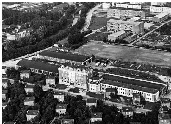
Zdeněk Plesník, celkový pohled na areál městského dopravního podniku, Zlín, 1955–1958, archiv KGVUZ
