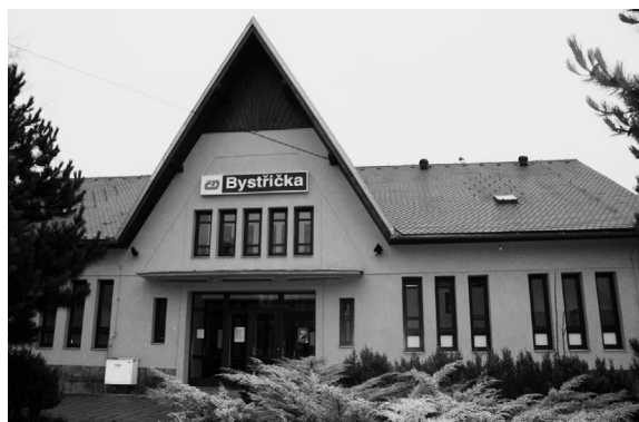
Budova nádraží Bystrčicka, foto: Helena Šířinová
