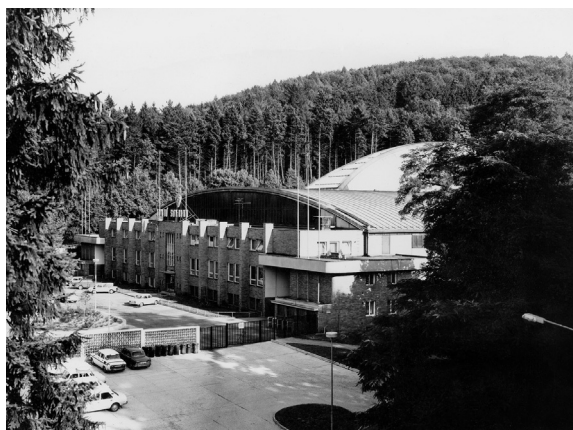
Ing. arch. Š. Zelina, Ing. arch. J. Kriskhe, Zimní stadion ve Zlíně, 1964, foto archiv KGVUZ
