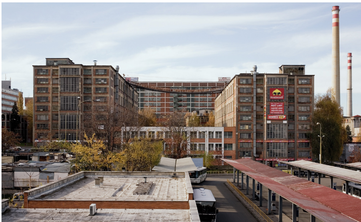
Stávající stav, foto: L. Stavjanik
