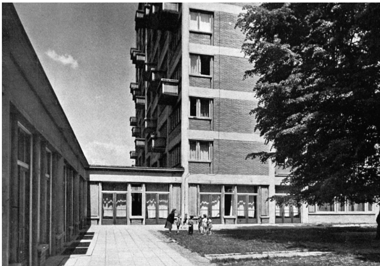
Jiří Voženílek, Kolektivní dům ve Zlíně, 1951, pohled jižní, foto Věra Pospíšilová VÚVA
