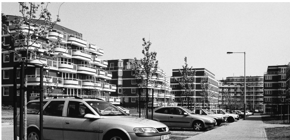
Karel Prager, domy U Kříže, pohled do ulice, Praha-Jinonice, 1999.
