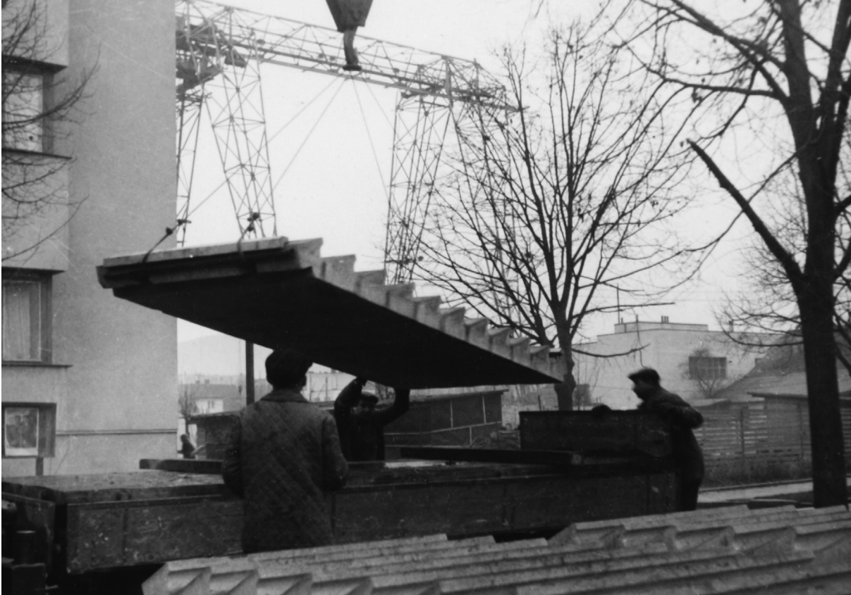
Výstavba prvního montovaného domu G 40, stavba schodiště, sbírka architektury KGVU ve Zlíně.
