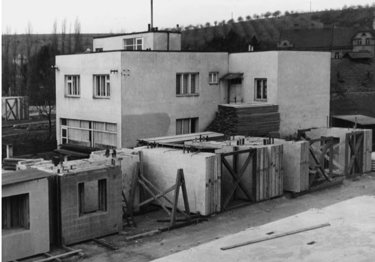
Výstavba prvního montovaného domu G 40 ve Zlíně na nábřeží u vily pana Chudárka v roce 1953, složené panely pro výstavbu, sbírka architektury KGVU ve Zlíně.
