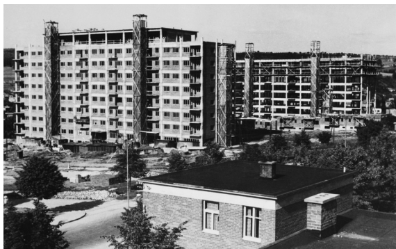
Výstavba chodbových (Morýsových) domů od architekta Miroslava Drofy ve východní části Zlína v roce 1947, sbírka architektury KGVU ve Zlíně.
