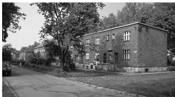
Pohled do obytné čtvrti v Chelmku, foto Rudolf Červenka 1998
